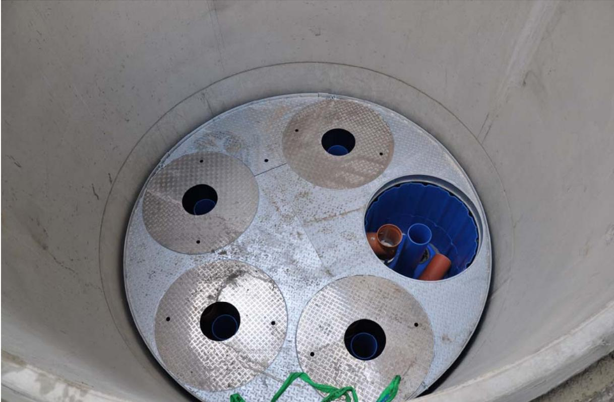
Fünf Filterelemente mit hoher Kapazität in einem Schacht verbunden: So bleiben Boden und Grundwasser unter dem Deutschen Theater München sauber.
