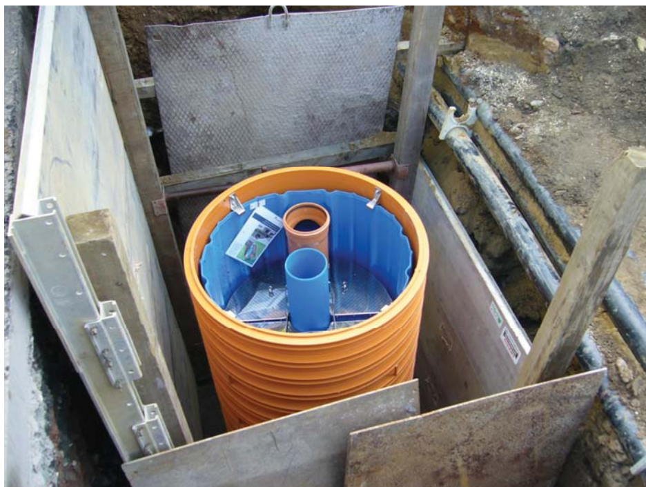
Abbildung 59: 3P ohne Schachtdeckel in der Baugrube
