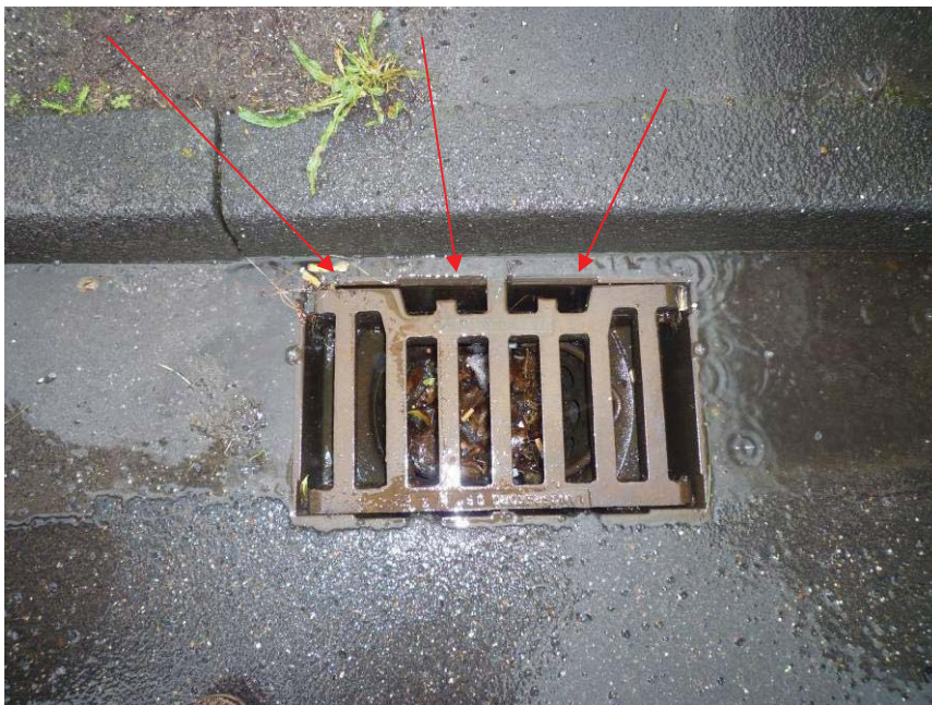
Abbildung 60: Zufuss zum Filtersack im Straßenablauf PL-07:
