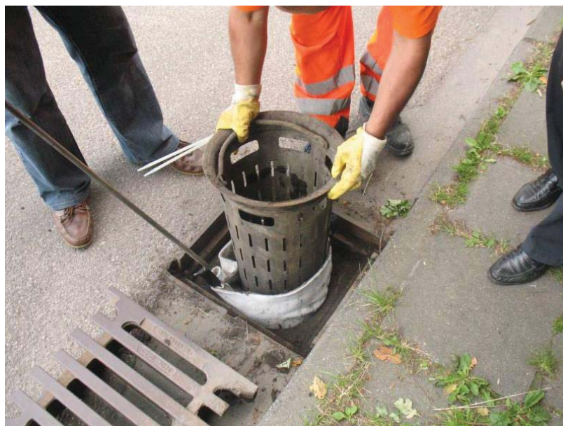
Abbildung 1: Einsatz des Geotextil-Filtersacks
