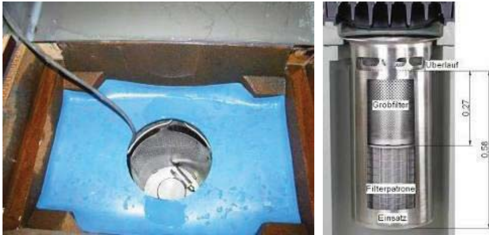
Abbildung 26: Links: Blick von oben in den Grobfilter des INNOLET® mit Adapterplatte (blau) und positionierter Drucksonde. Rechts: Aufbau INNOLET® (Quelle: Funke Kunststoffe GmbH, verändert).
