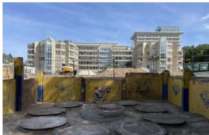
BGU Frankfurt a.M.: Zentraler Bestandteil beim Bau neuer Regen-/Mischwasserkanäle und Versickerungssysteme ist ein spezielles Hydrosystem zur Reinigung von stark belastetem Oberflächenwasser. Foto: Finger Baustoffe GmbH
