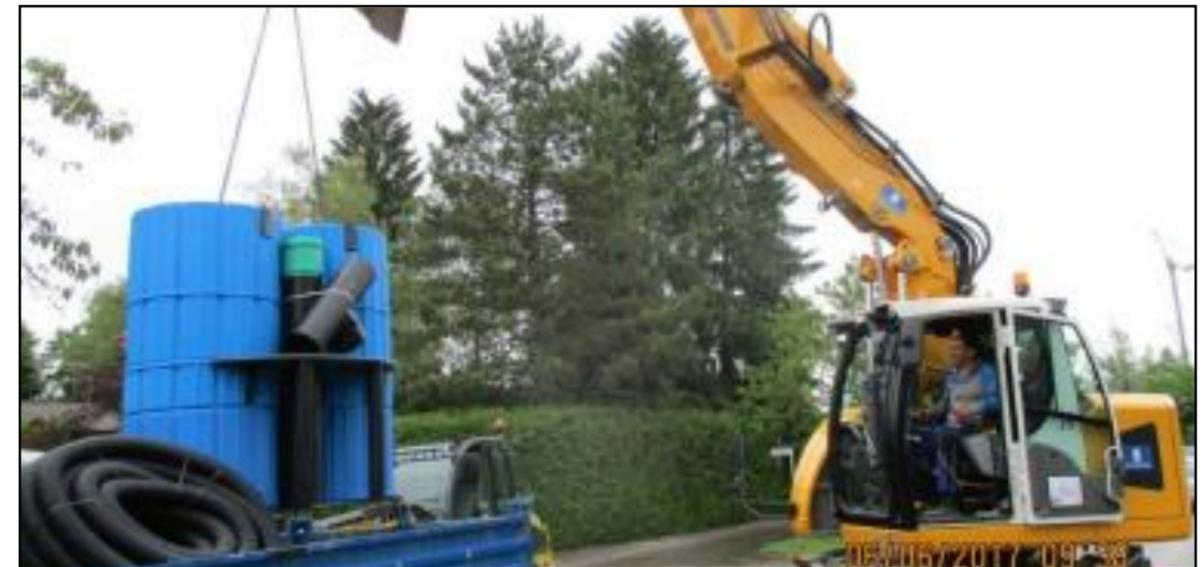
Auf Grund der kompakten Bauweise und den leichten Materialien ist das Versetzen des Systems mit einem Baustellengerät möglich, welches auf jeder Tiefbaustelle vorhanden ist.
