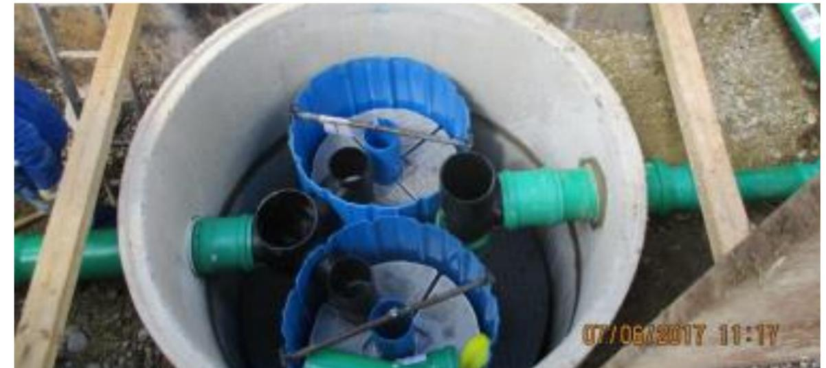
Eingesetzte Behandlungsanlage **Hydrosystem heavy traffic** in der Zwillingversion. Zulauf rechts im Bild, Ablauf entsprechend links, wobei die Winkelverhältnisse variabel sind.
